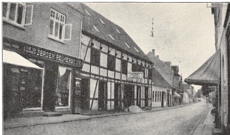
Fig. 4. Det kærstrupske Magasin i Nysted (før Ombygningen 1928).
