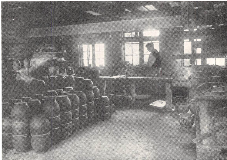
Pottemagerværkstedet som det saa ud til Nedlæggelsen 1933. I Forgrunden til venstre halvtørre Krukker færdige til „Beløbning“. Til højre Kakkellovnen med Fade til Tørring.
