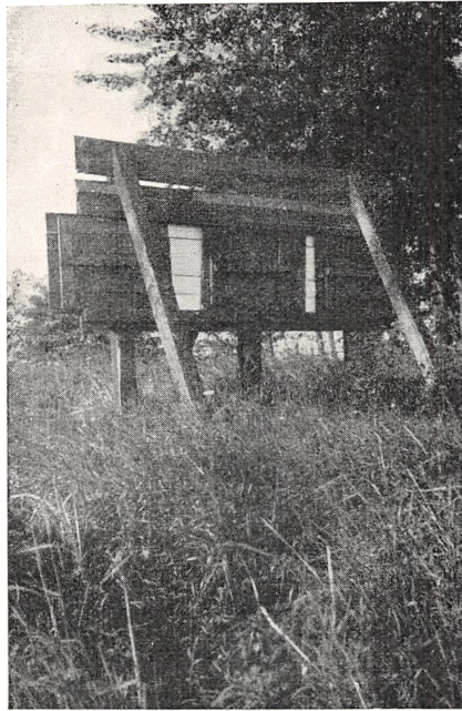
Fig. 3. Signalet, der indtil for faa Aar siden benyttedes til at kalde Færgen fra Møn. Naar Skodderne fjernes, kommer et hvidmalet Felt tilsyne, der kan ses fra Færgestedet paa Møn.
