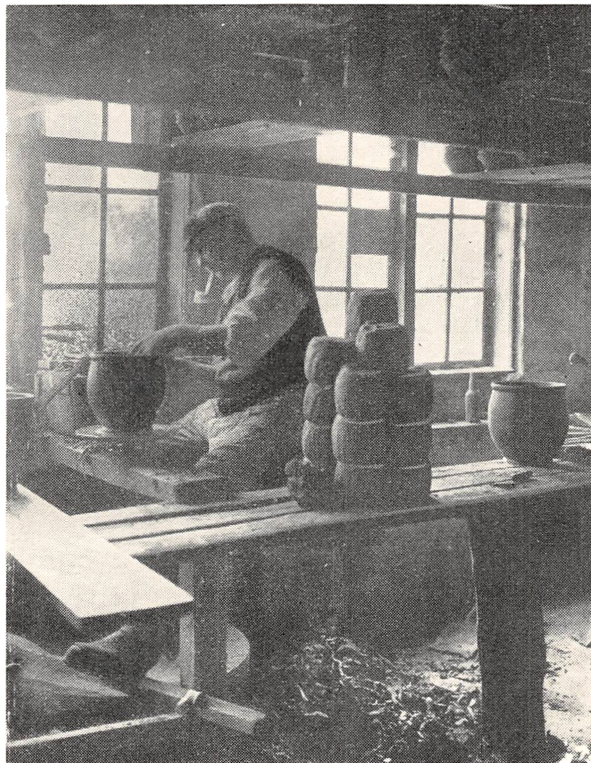
Drejning af Krukker. „Kløsene“ i Stabelen viser, hvor stor en Klump Ler der gik til en saadan Krukke.
