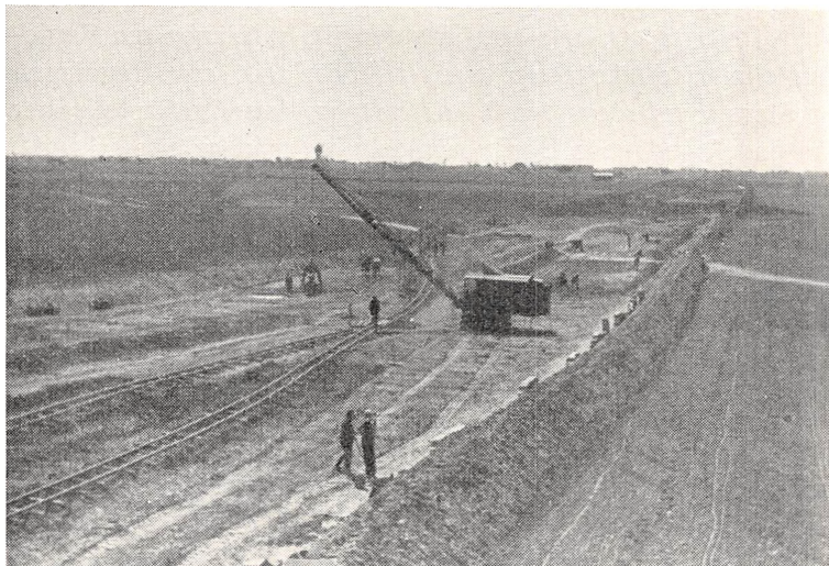
Fot.: Ingeniør G. Frandsen, Maribo Fra Arbejdet paa Autostradaen Rødby Havn—Storstrømsbroen
