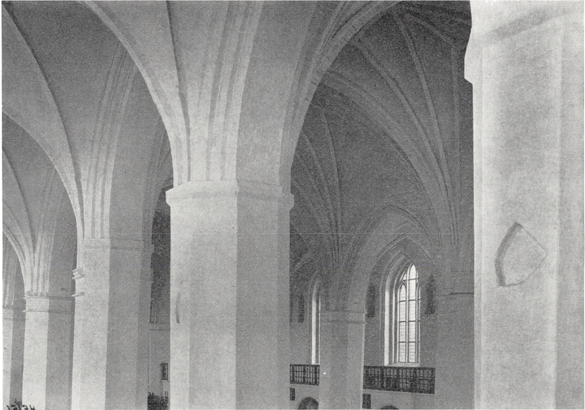
Fig. 31. Sydsidens vestligste arkadepiller, forsynede med skjoldformede blændinger, som måske har båret våbenskjolde for klosterkirkens fornemste velgørere, se p. 488.
