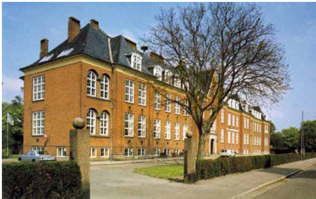
Den fraflyttede sygehusbygning i Bispegade, i dag UCSJ og VUC.
