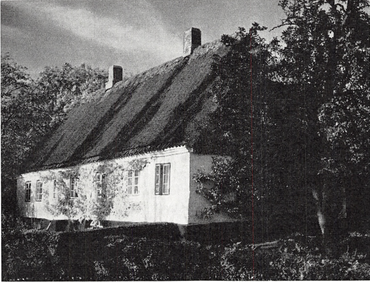
Stavreby skole (sydfacade). Oprindelig længde 21 alen, men 8 alen tilføjet mod vest til skolestue; denne har samme mål som Assenbølles. Vinduerne mod vest har bevaret buen, men er mod øst forhøjet.
