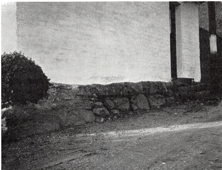
Det svære kampestensfundament (højde 1 alen). Trappetrinene antageligt de gamle, der er flyttet fra deres oprindelige plads.
