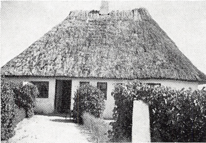
Det sidste Hvilehus ved Sæbyholm (1958).
