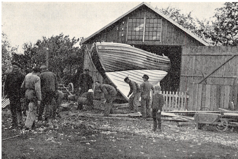
Lystjagten »Solstraale«, konstrueret af og bygget til civilingeniør Knud E. Hansen 1939. Jagten trækkes ud af værkstedet før søsætningen.
