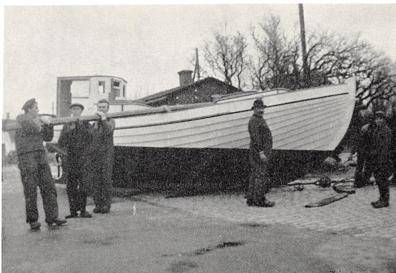
Transport fra værksted til havn af fiskebåd »Gerda« af Askø før søsætningen 1937. Over båden er lagt en bundgarnspæl, surret til røstjernene, rækkende ud til styrbords side og støttet af tre mand for at holde den i balance. Båden trækkes over træstykker, smurt med grøn sæbe («udskør», »fedtlapper»). Under forstævnen ses taljeblokken. Søsætningen skete med motoren installeret; samme dag kunne »Gerda« sejle hjem til Askø. — Fot. fru skibstører Christensen, Fejø.
