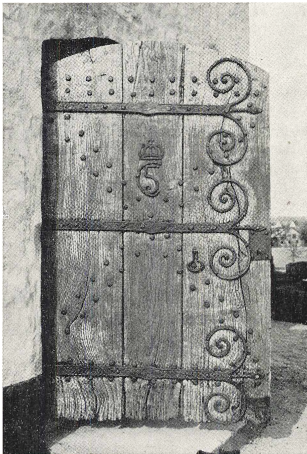
Dør til våbenhuset ved Tingsted kirke omkring 1688—89.
