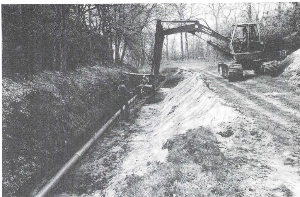
Fig. 3. Udgravningen i noret indledtes med, at de øverste 1,5 m sandlag over de mest udsatte dele af vraget fjernes med maskine. Foto: Falsters Minder.
