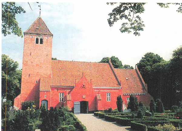
Fig.4. Vålse Kirke er ved tårnets tag repræsentativ for de kirker på Lolland og Falster, som har eller tidligere har haft pyramidetag, og desuden for de såkaldte pinakler på gavlhjørnerne ved skibets og våbenhusets tage. På våbenhusets gavl findes tilmed et ekstra sæt. Her er således fem pinakler i stedet for de sædvanlige tre. Kirken rummer en smuk, trefløjet sengotisk altertavle. Foto: Bendt Jepsen.
