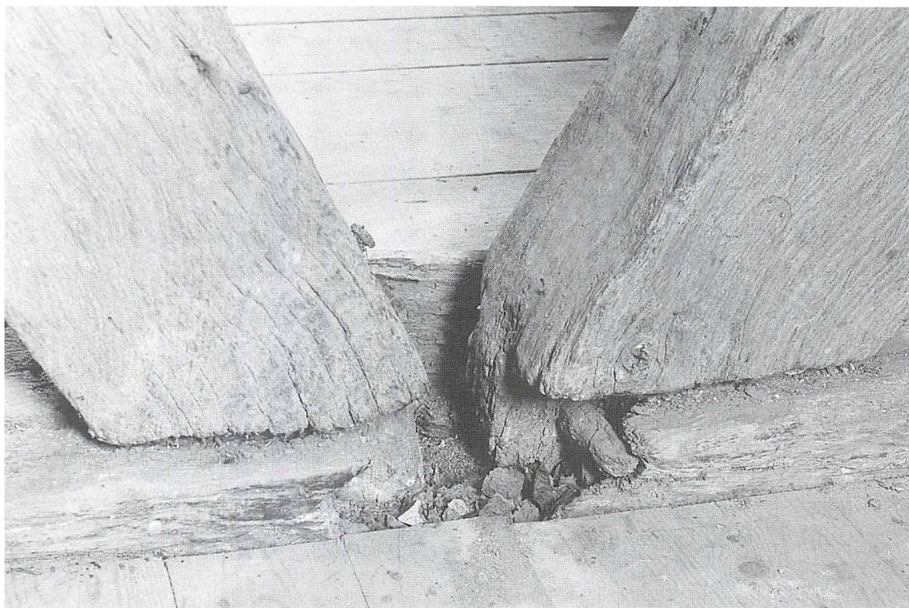
Igenennem trehundrede år var klokkestolens tømmer blevet beskadiget af råd. Her ses skråstivernes tappe, som ikke længere står i et præcist udstemt taphul, med et stort krater.
