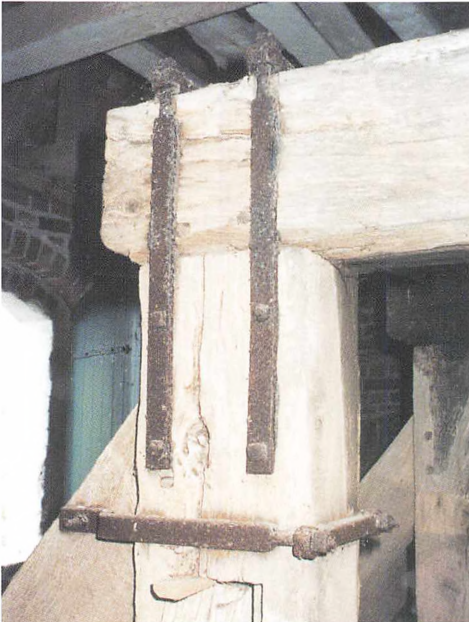
Jern har en stor styrke og var også brugt til sikring ved klokkestolens sammenhæng; men på langt sigt har jern den skavank, at det rustet og derved udvider sig kraftigt. Ved restaurering blev alle jernbeslag fjernet. De oprindelige tømrede samlinger blev atter gjort funktionsduelige.
