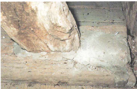
En af de lange skrånstiveres tapforbindelse ved remmen var blevet sikret med cement. En meget uholdbar løsning, fordi remmen fortsat rådner omkring cementfyldingen, som hurtigt bliver en løs protese.
