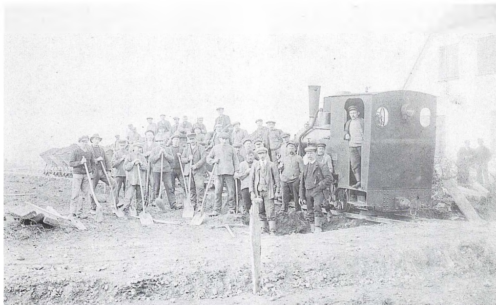
Far med sit lokomotiv under bygning af Kragensbanen.
