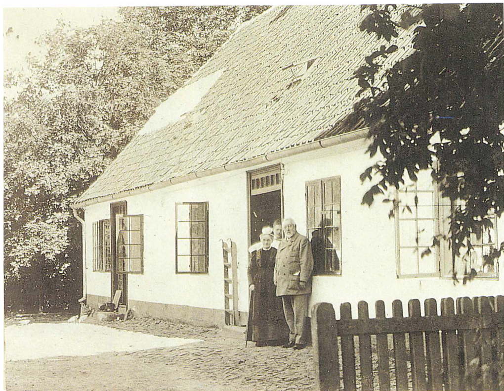
Fig. 5. Skovrider Wegge, hans kone og søster ved hoveddøren fotograferet af sønnen Paul Wegge 1901. Det i 1905 nedrevne stuehus var mere lavstammet end det nuværende. Reventlow-Museet.
