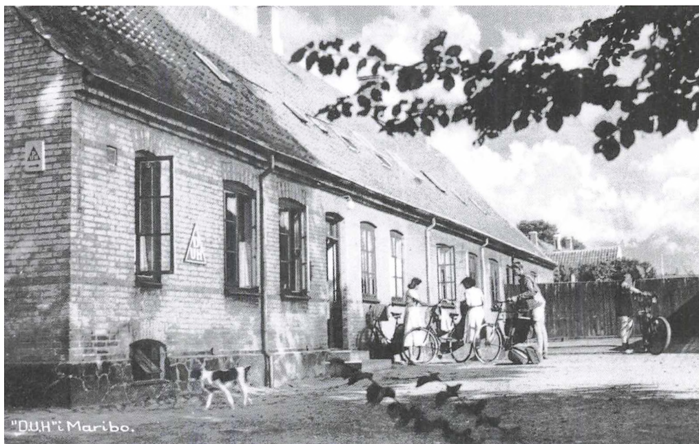
Fattiggårdens bagside. På dette tidspunkt er bygningen omdannet til vandrehjem. Maribo Lokalhistoriske Arkiv.
