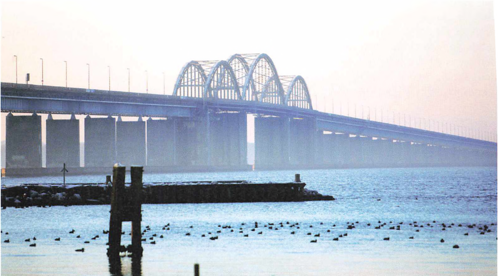
Storstrømsbroen fotograferet i 2012. Foto: Ingrid Riis.
